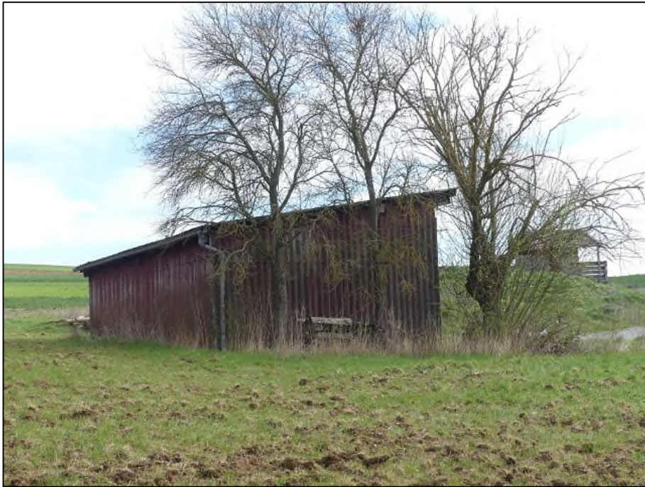
Abb. 4: Feldscheune Fl.Nr. 1183/1, Blick nach Norden (03.04.2023)
